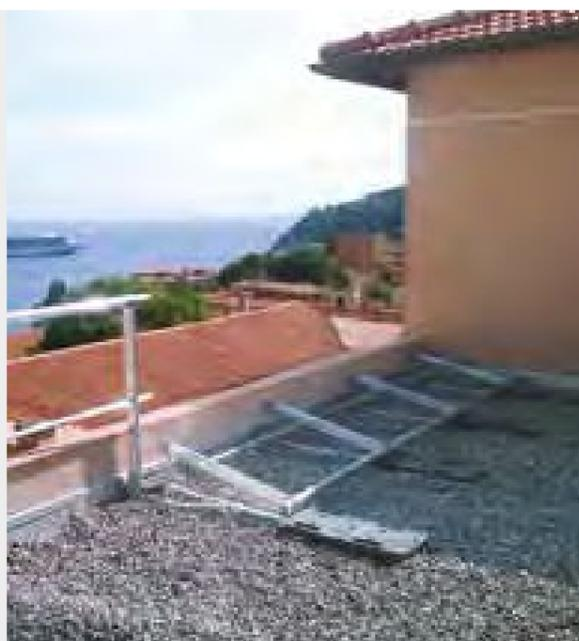
**PARAPETTO RAPID 1 PER FISSAGGIO SU LAMIERA**
